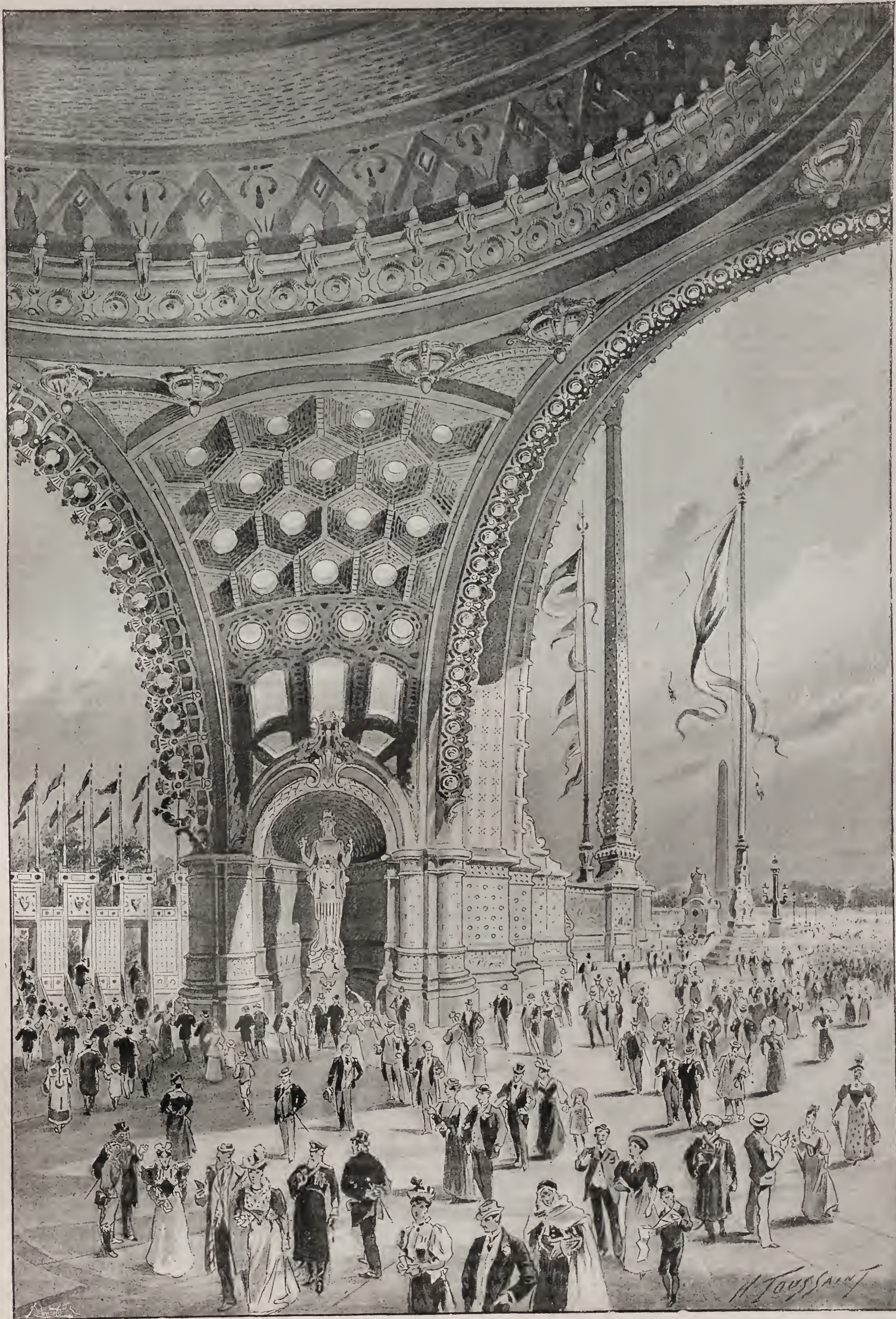
Le dessous de la Coupole et le grand arc, vus de l'intérieur.
